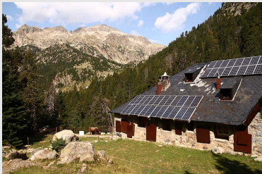
Refugi de l'estany Llong, Aigüestortes a 1985m d'alçada
